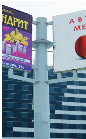
Рис. 10. Фото усиленной конструкции
