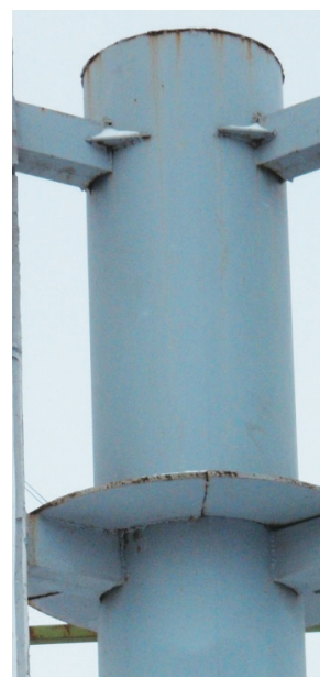
Рис. 8. Предлагаемый вариант усиления
